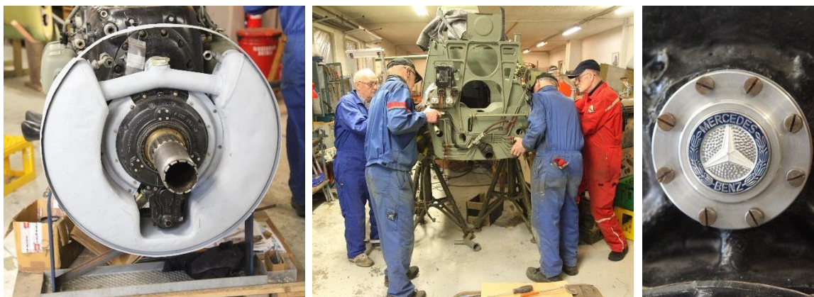
Oljetanken som ikke passet til venstre, i midten monterer Arne Lende, Kjell Naas, Kristian Helland og Sverre Sollid utstyrskassen bak motoren i midten. Til høyre er fabrikantens merke kommet på plass på motoren.
